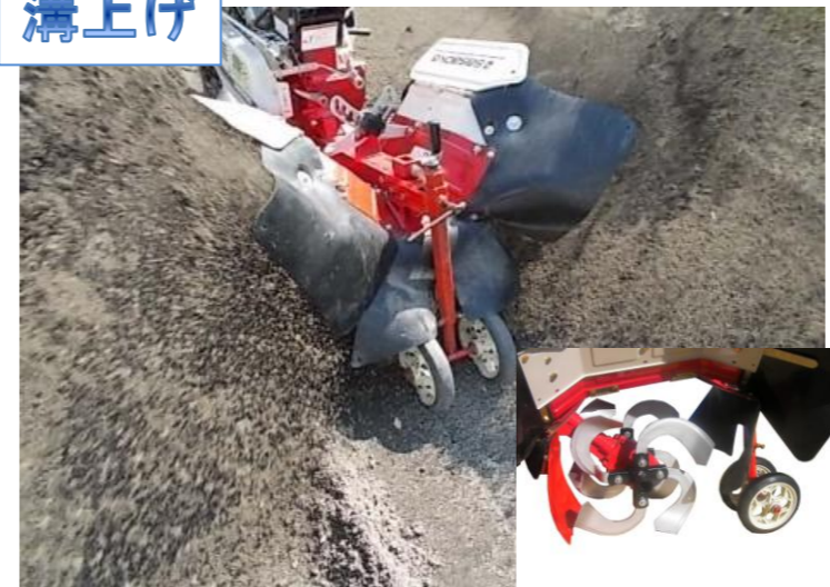
安定した溝上げ作業。手直しなしの均一ベツ
